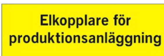
Bild 12. Exempel på skylt som utmärker elkopplare för produktionsanläggning.
